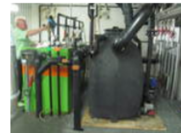
Bild: © Erfinder Johannes Rainer bei der Anlage im Krankenhaus Krems
